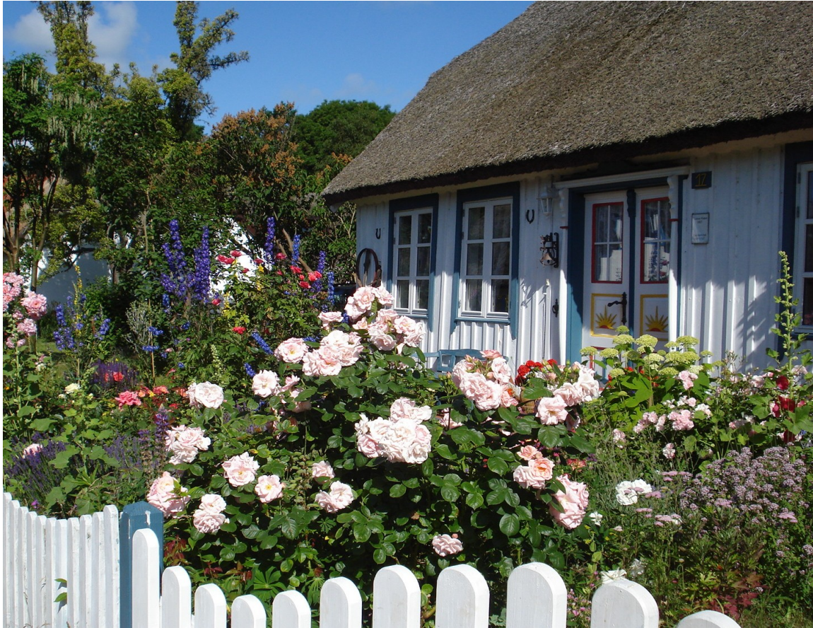
Abb. 9 Unser Halbbüdner – Katen in Born in noch originaler Bausubstanz aus Rohr, Holz und Lehm, Baudenkmal NVP 197.
